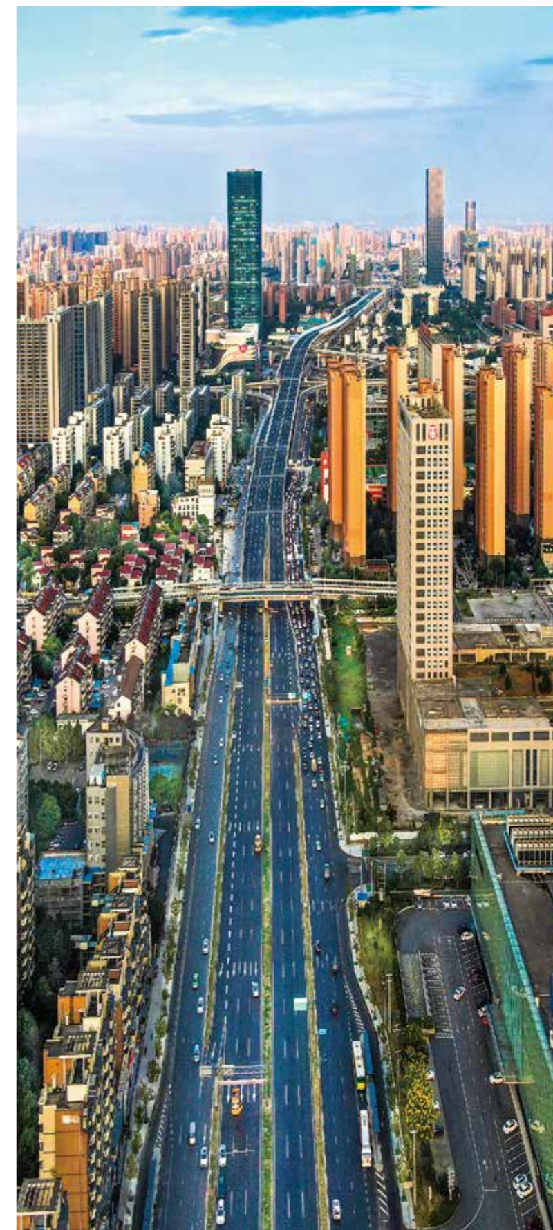
改造完成后的南二环全景照片
