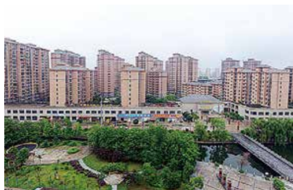
位于合肥的首个应用装配式建筑的项目 安建·锦绣花园
