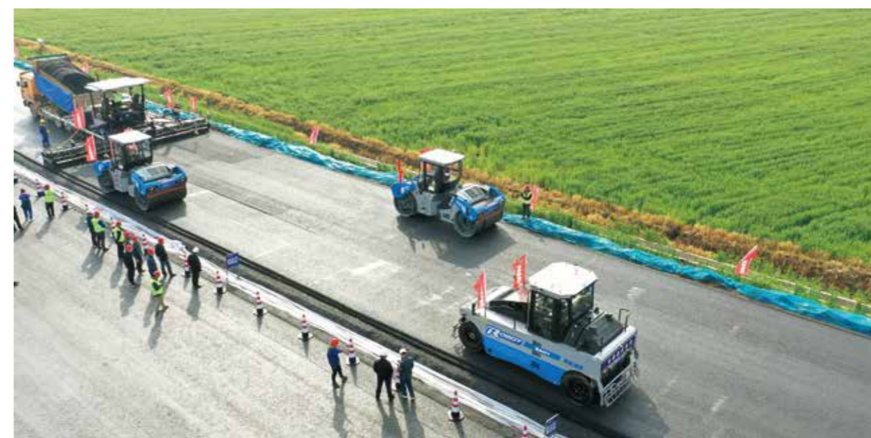
路桥集团试点应用路面摊铺无人智能化操作技术
