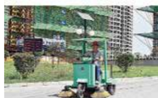
施工现场须有专人保洁 硬质路面应整洁无积灰 行车路面应保持湿润
