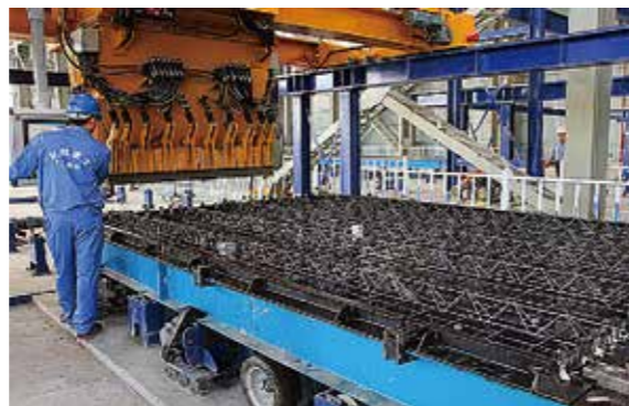
PC构件产业工人正在进行叠合板浇筑操作
