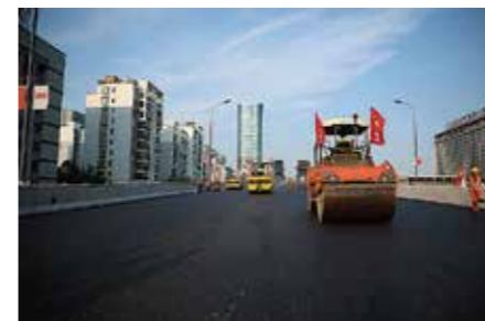
主桥沥青摊铺施工
