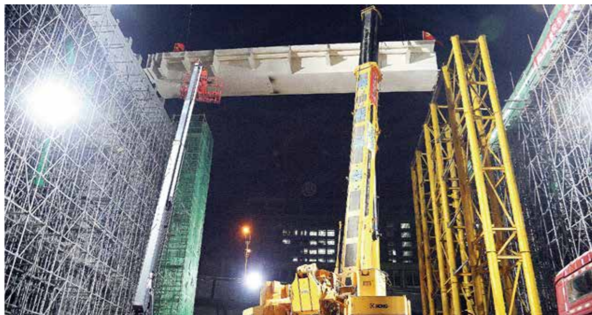
连夜进行首片钢箱梁架设
