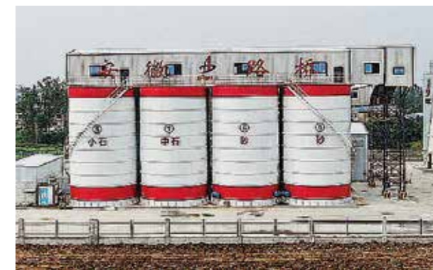
安徽建中仓智能制造有限公司拌合站
