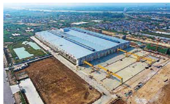
安徽建工嘉和建筑工业绿色建筑产业园鸟瞰
