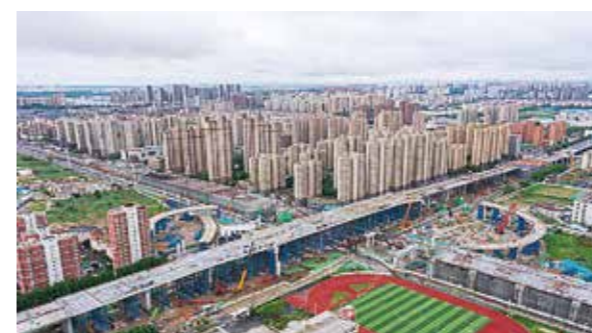
位于肥东县的包公大道道路及管廊工程，主线桥全长2.22公里，匝道2.82公里，造价11.93亿元。
