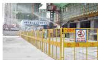
施工现场设置洒水或雾化降尘设施 定时洒水降尘
