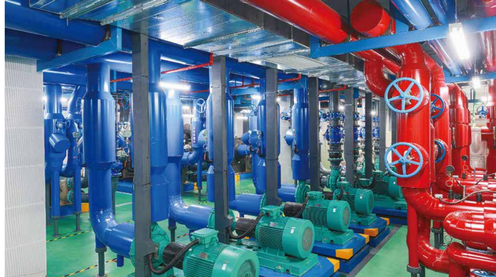
中国安装之星——中国科学技术大学物质科学教研楼安装工程
