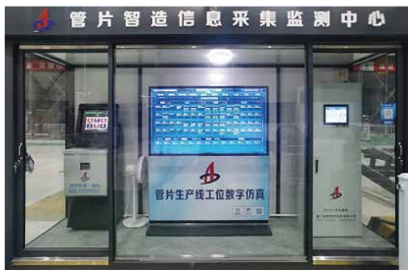
安徽建工中仑智能制造有限公司管片智造信息采集监测中心
