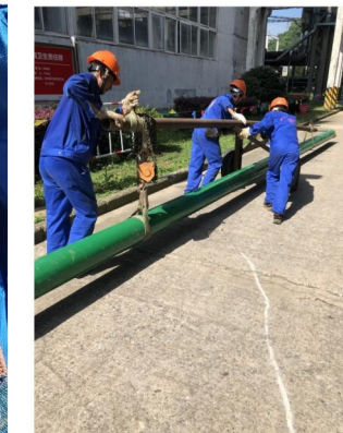
拍摄者：肖健 安庆石化腈纶阻燃纤维生产技术改造共聚项目 人工倒运管道
