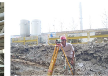
拍摄者：王浩 阜阳市颍东区中医院建设 PPP项目部医技楼汽车坡道基层平整标高测量
