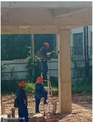
拍摄者：肖健 安庆石化腈纶阻燃纤维生产技术改造共聚项目 桁架焊接
