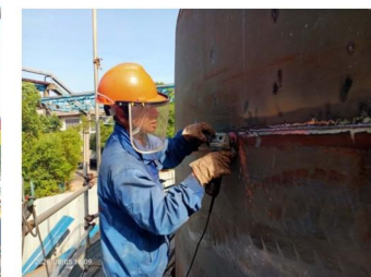
拍摄者：孙维维 安庆石化腈纶阻燃纤维生产技术改造共聚项目罐区焊接打磨
